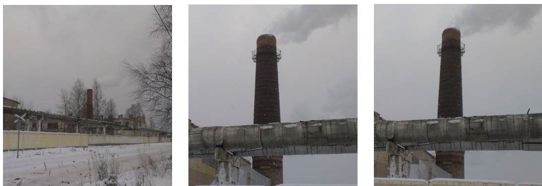
Рис. 4. Фотографии выхода дыма из трубы котельной №4 города Мирного
