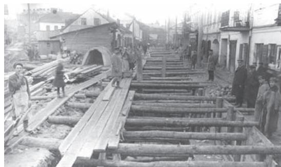
Рисунок 2. Строительство подземных коллекторов
