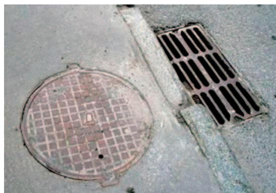
Рисунок 8. Люки и решётки ливневой канализации
