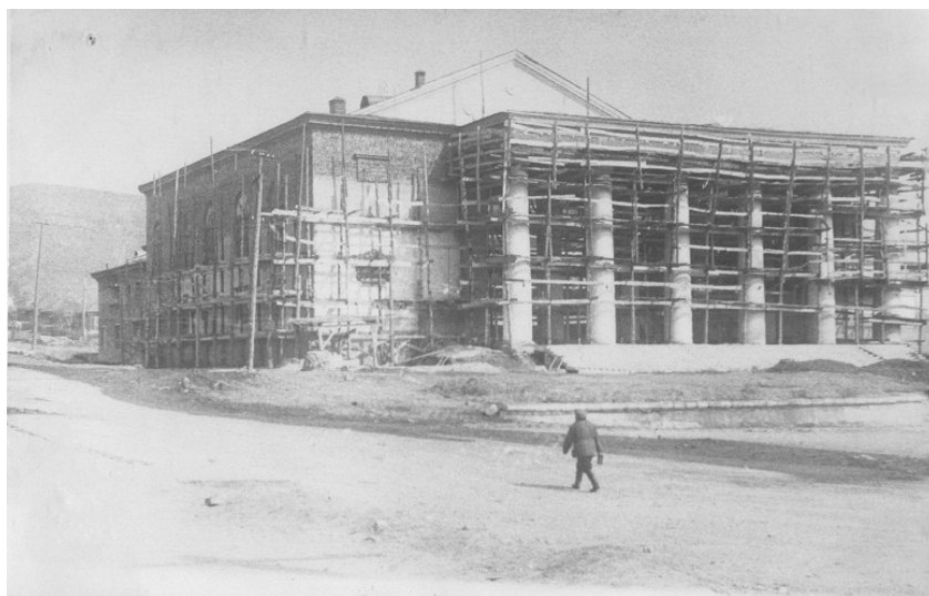
Фото 10. Строительство Дворца культуры
