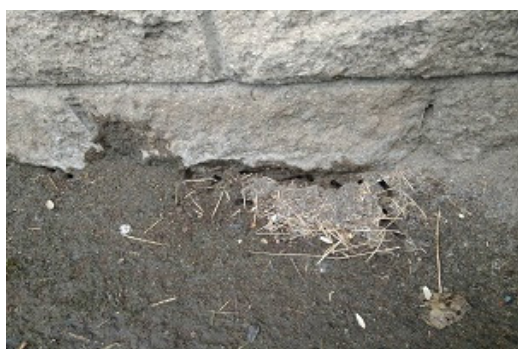
У основания здания (г. Пермь)
